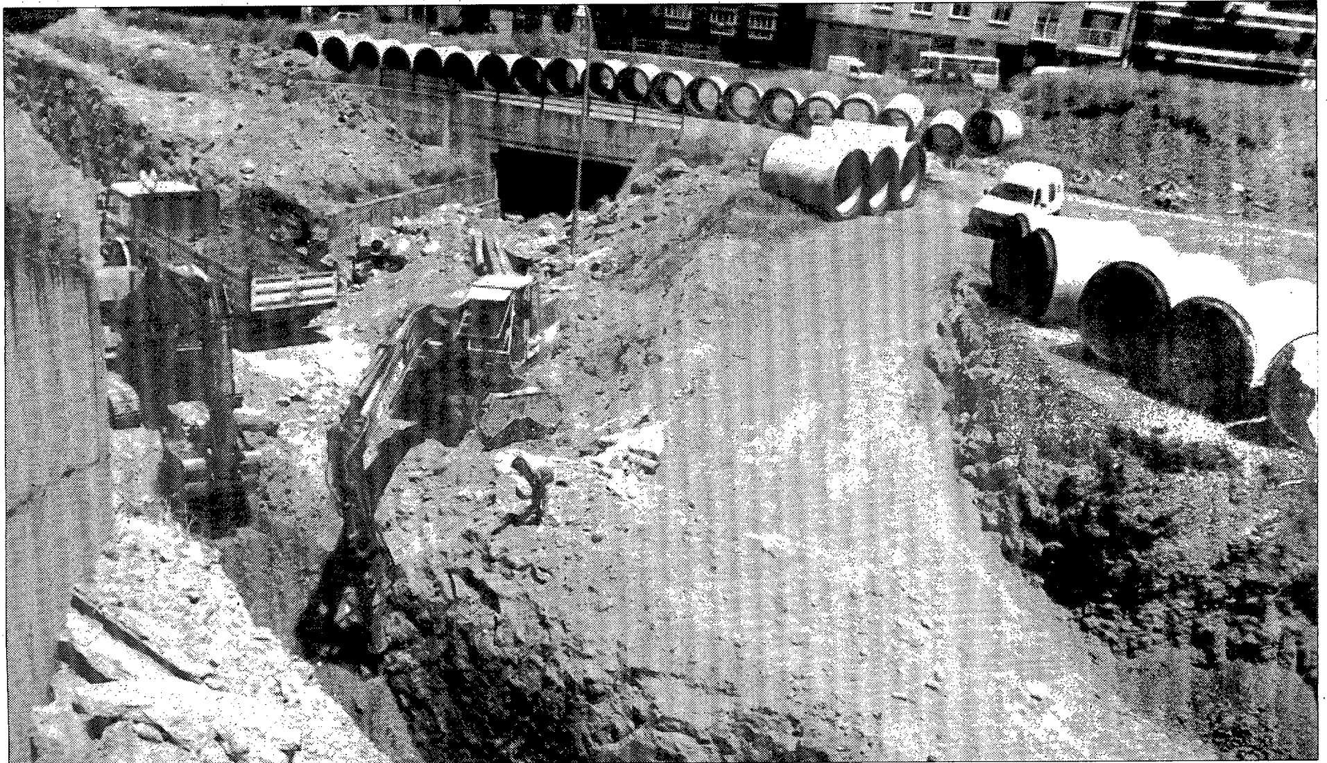
Aspecto de las obras en los antiguos terrenos de Renfe
